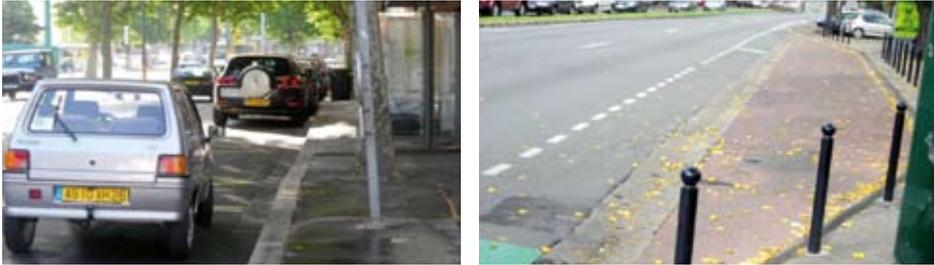
Figure 50 : Photos arrêt en encoche non accessible ou mal dimensionné
