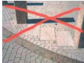
Les BEV ne doivent absolument pas être positionnées ainsi (recommandations concernant les surfaces tactiles au sol pour personnes aveugles ou malvoyantes, CERTU)
