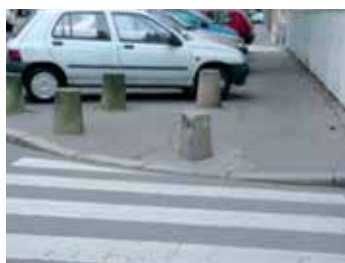
L'abaissement de trottoir est encombré par une borne (accessibilité de la voirie et des espaces publics, CERTU)
