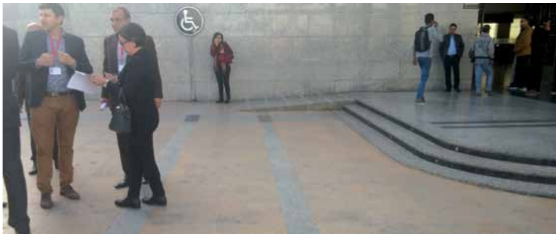
Prise en compte des PMR pour l'accès à la gare sauf que l'emplacement de la rampe n'est pas optimal
