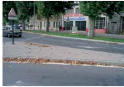
Absence de traversée
