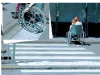
Le ressaut est supérieur à 2 cm (accessibilité de la voirie et des espaces publics, CERTU)
