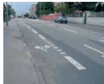
Revêtement de mauvaise qualité
