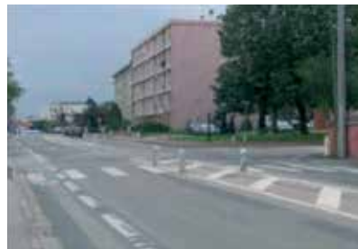
Traversée non protégée
