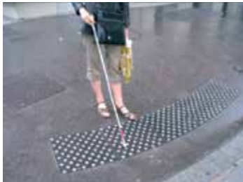
La BEV est bien disposée mais peu contrastée, attention au glissement sur les plots (photo A. Louis)
