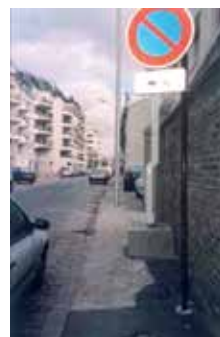
Le cheminement est étroit et encombré ( http://environnement-transport.hauts-de-seine.net/portal/site/environnement/norme-ufr/personne-mobilite-reduite/amenagement/1138/ )
