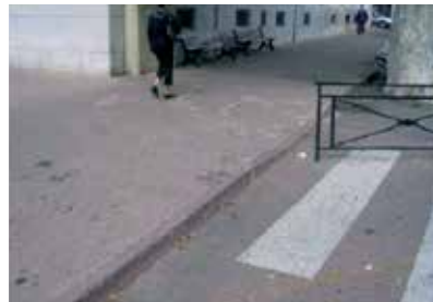
Pas d'abaissement de trottoir
