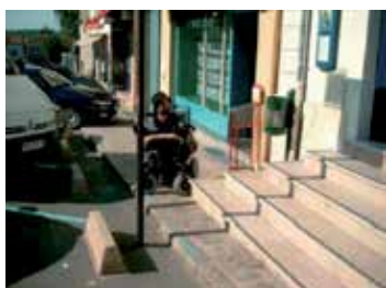
Le cheminement est encombré par des marches ( http://www.circulationsdouces91.org/espace%20enfants.htm )
