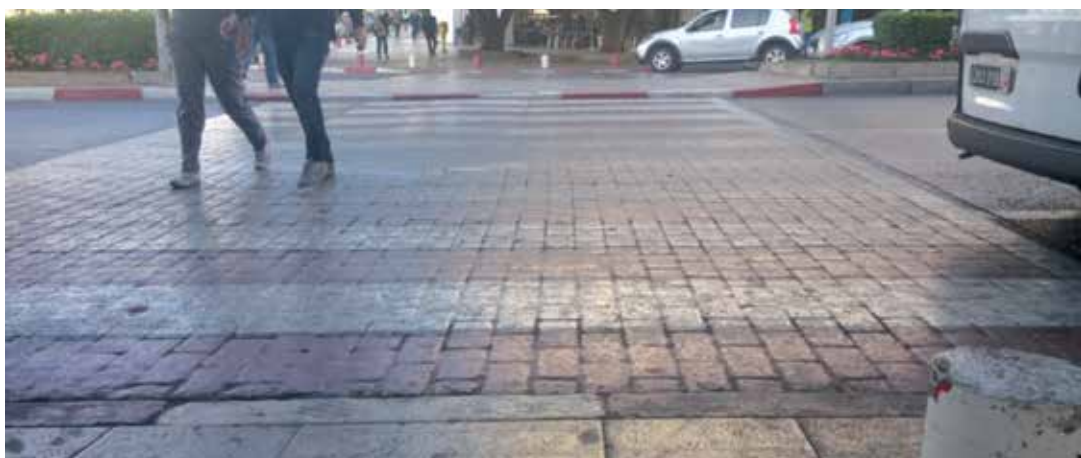
Abaissement du trottoir au niveau de la traversée piétonne, bien marquée et régulée, sur Av. Mohammed V
