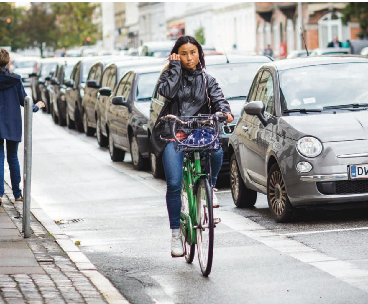
Foto 26. Ciclovía emplazada entre la acera y la faja de estacionamientos. Esta última actúa como separador del flujo motorizado. Copenhague, Dinamarca Fuente: Claudio Olivares Medina
