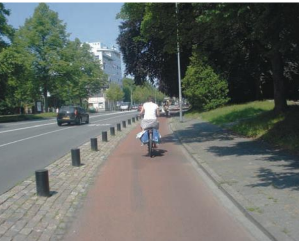
Foto 18. Ciclovía unidireccional integrada a la calzada, Groningen, Holanda. Fuente: Patricia Calderón.
