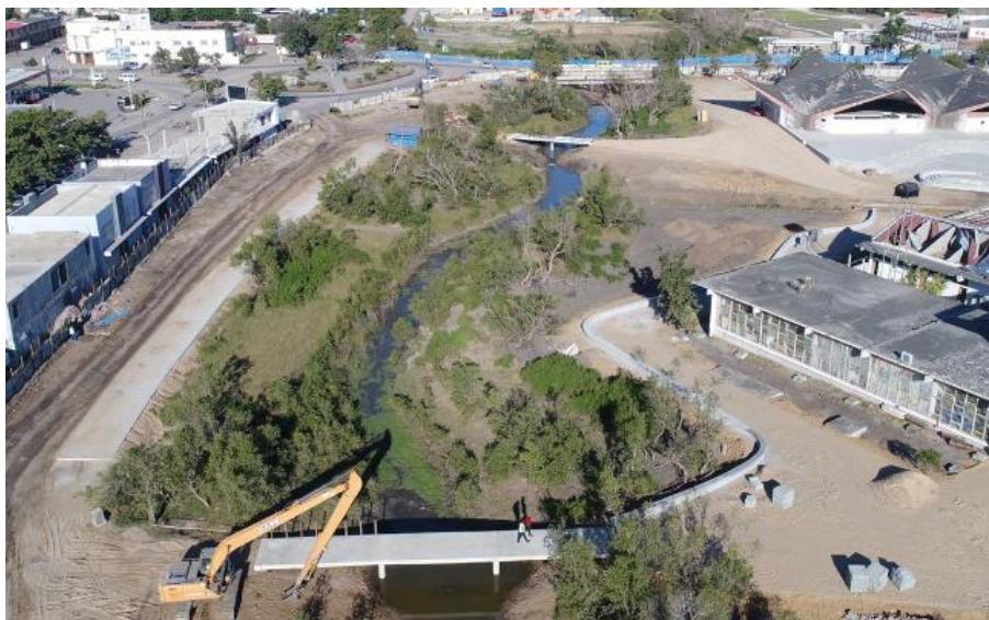
Figure 2: Projet Chiveve Rio et Infrastructure Urbaine Verte en phase de construction.
